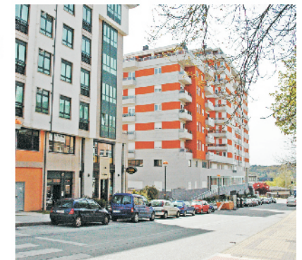
El empleo de materiales específicos puede evitar parte del ruido aéreo. M. PERERA
